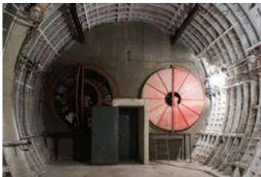
Рис. 3. Вентиляционная шахта метро
